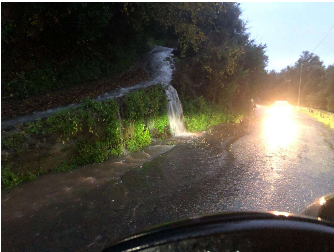
Fenomeni di allagamento strada provinciale S.P. 37 (Palmi – Tonnara)
